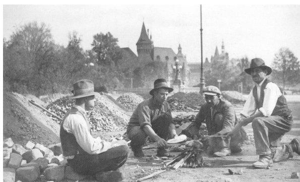
B) Útépítő munkások a Városligetben
